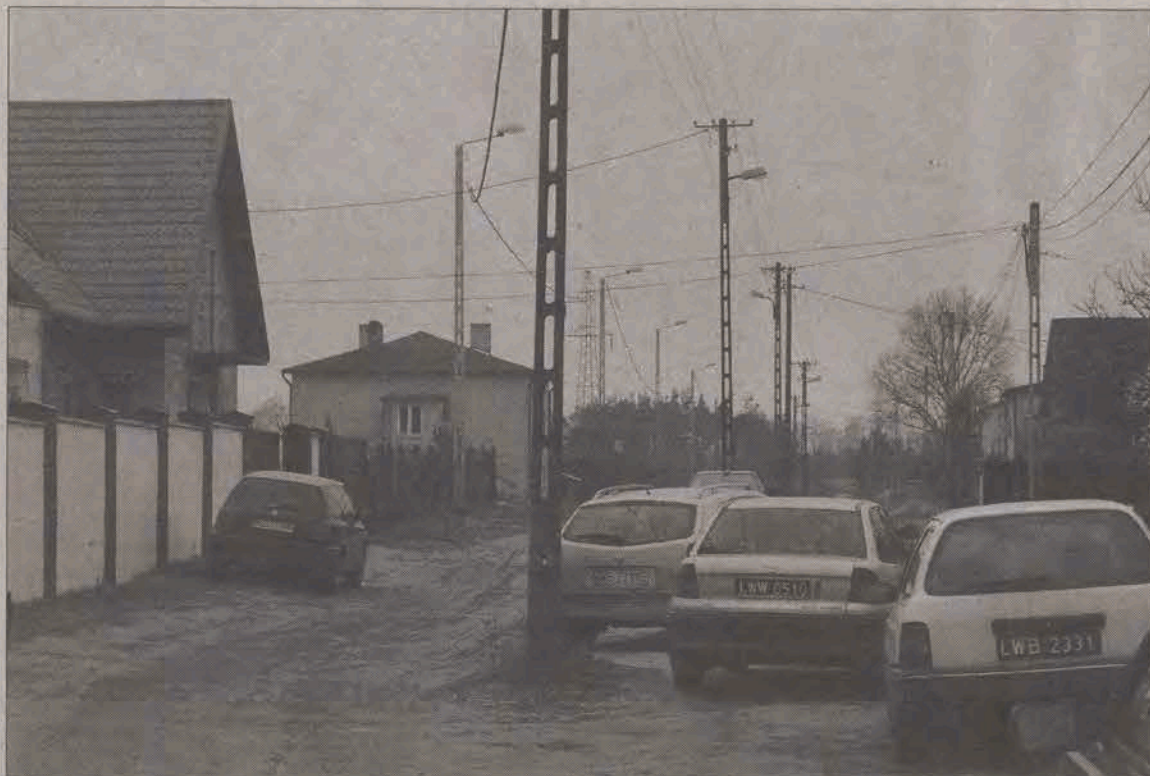
PRZESTAWIAJĄ SŁUPY NA TUVIMA. Pod koniec ubiegłego tygodnia rozpoczęła się przebudowa linii energetycznej w ul. Tuvima w Głownie. Jest to wspólna inwestycja Łódzkiego Zakładu Energetycznego oraz Urzędu Miejskiego w Głownie o szacunkowej wartości 100 tys. zł, w tym partycypacja miasta wynosi 50.000 zł. Za tę sumę wybudowana zostanie nowa linia napowietrzna po prawej stronie ulicy, wykonanie przyłączy do poszczególnych posesji oraz demontaż istniejącej linii biegnącej środkiem jezdni. (eb)
