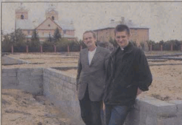
Pod koniec lata rozpoczęto budowę Domu Pogodnej Starości przy parafii na Bratkowicach. Na zdjęciu prezes fundacji budującej Dom Wojciech Urbanek i ks. Zbigniew Kaliński.
