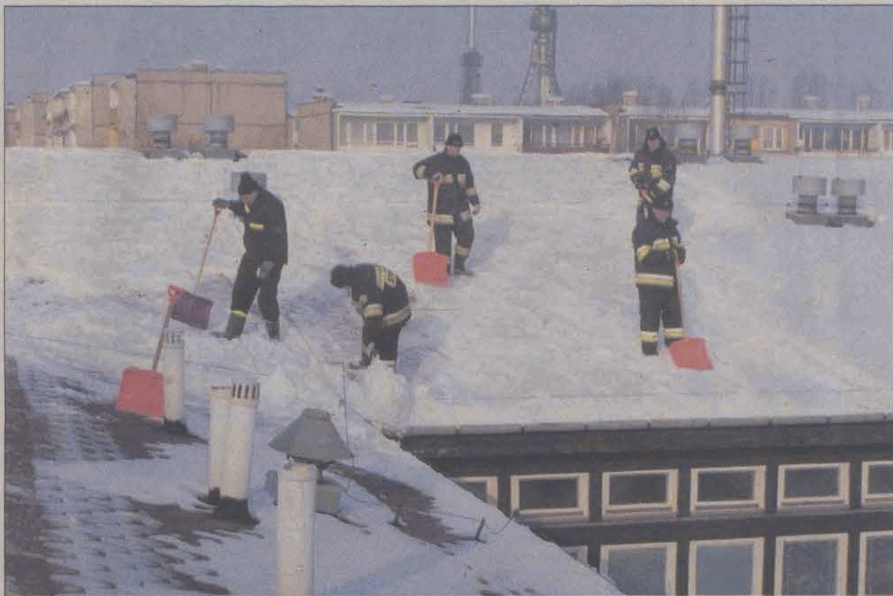
Rok 2006 był rokiem prawdziwej zimy i prawdziwego lata. Na przełomie stycznia i lutego usuwano śnieg z dachów, obawiając się, by się nie załamały tak, jak w Katowicach...
