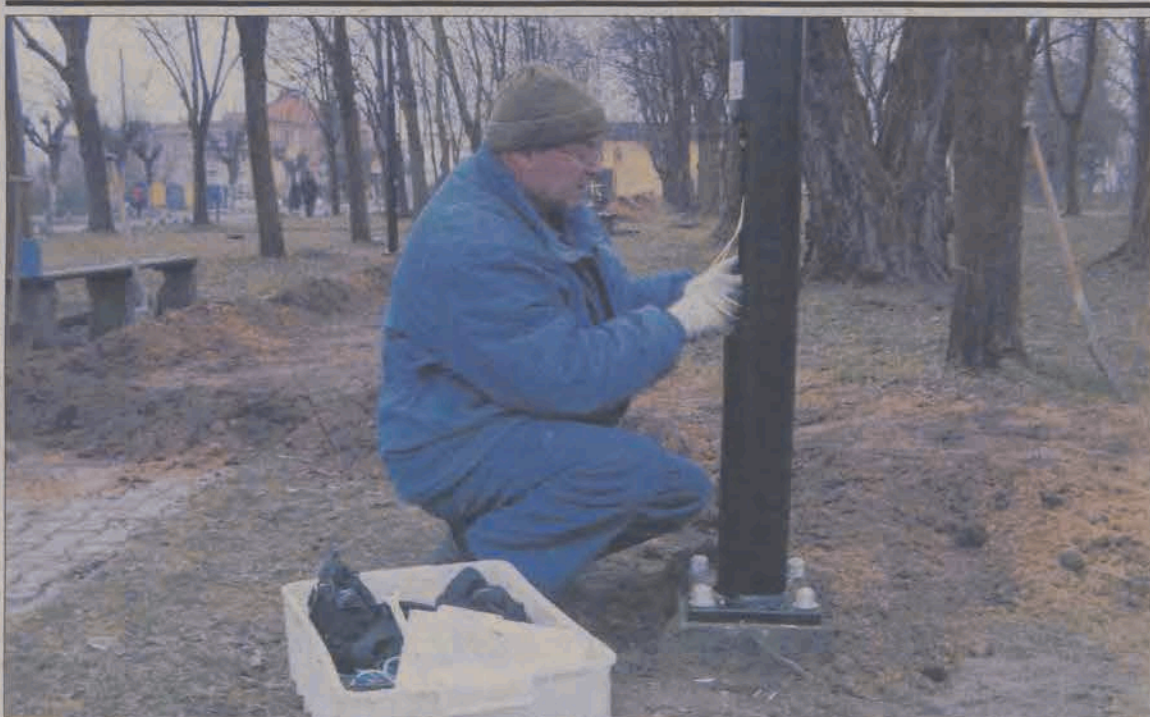
Bez nowych odkryć w parku. Dobięta końca instalacja nowego oświetlenia w parku przy Pl. Łukasieńskiego w Strykowie. Roboty ziemne musiały być prowadzone pod nadzorem archeologa, po tym, jak w pierwszych dniach inwestycji w pobliżu kościelnego parkanu odkryto ludzkie kości. W części parku znajdującej się wzdłuż ul. Kościuszki nie natrafiono już na szczątki. Sprawujący nadzór archeologiczny Wojciech Dudak sądzi, że wokół kościoła znajdował się cmentarz. Jego zdaniem kości ludzkie mogły znaleźć się za kościelnym parkanem z dwóch powodów: albo współczesne ogrodzenie kościoła nie odpowiada pierwotnym rozmiarom zlikwidowanego cmentarza, albo natrafiono na szczątki osób, które wedle zwyczaju nie miały prawa do pochówku na cmentarzu i grzebano je za parkanem. Kości zostaną opisane, a następnie pochowane na dzisiejszym cmentarzu. Nie przewiduje się poszerzenia wykopalisk.
