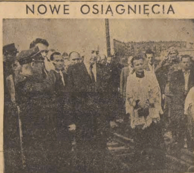
22 lipca br. premier, tow. Cyrankiewicz Józef dokonał otwarcia nowego mostu kolejowego w Warszawie koło Cytadeli. Foto—SAP
