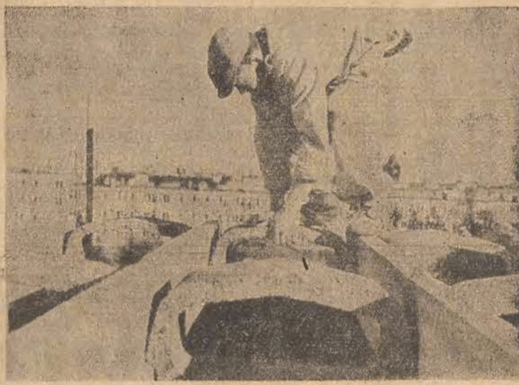
XIII Kolonia Warszawskiej Spółdzielni Mieszkaniowej („Szkłane Domy”) powstaje dosłownie z gruzu — zastosowano bowiem przy jej budowie tzw. „garnki” fabrykowane z gruzu cegielnianego, którego przecież w zrujnowanej stolicy nie brakuje. Foto SAP
