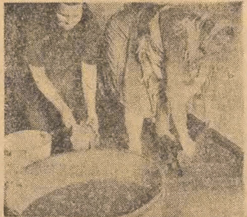
Mieszkancki górnych pięter zbierają wodę, aby nie przeciekło na niższe piętra
