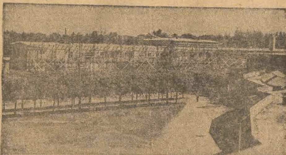
Odwiedzający Wystawę Ziemi Odzyskanych we Wrocławiu — mają napawioną estetycznie urzędową „bazę aprowizacyjną”. Będzie się ona mieścić w tym oto efektywnym pawilonie restauracyjnym.
