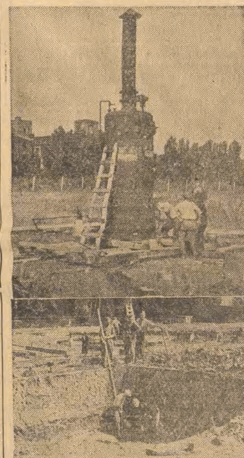
Prace ziemne przy budowie hali sportowej w Łodzi, szybko posuwają się naprzód.
