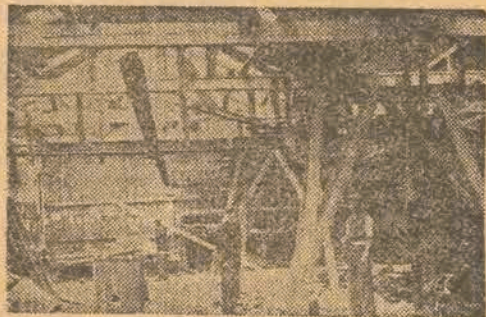
W szybkim tempie postępowała naprzód budowa poszczególnych hal
