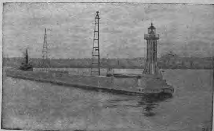
Tegoroczne inwestycje w Gdyni dotyczyły głównie zabudowy nabrzeży portowych. Zdjęcie powyższe przedstawia główne wejście do awanportu, oraz latarnię wejściową dla sygnalizacji „mgławiej i antenowej“.
