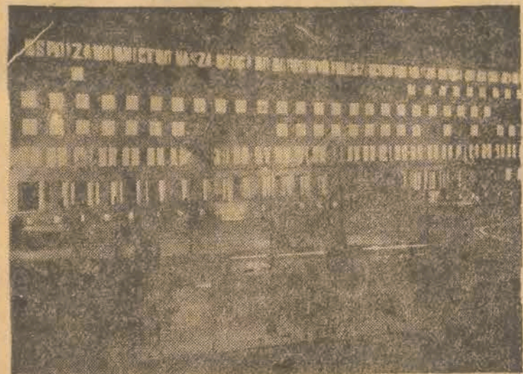
Oto tempo odbudowy i budowy: ten wspaniały aluminiowy gmach — to nowoottwarty budynek Ministerstwa Przemysłu i Handlu. Budynek ten powstał w rekordowym czasie 14 miesięcy, podczas gdy normalnie w Polsce przedwojennej i za granicą budowa takiego olbrzyma trwa 3—4 lat.
