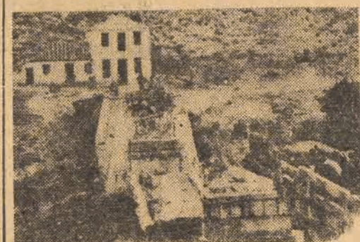
Zburzony most pod Tripolis.
