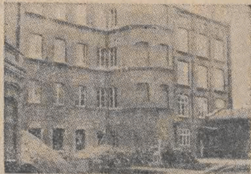
Remont budynku dobiega końca
