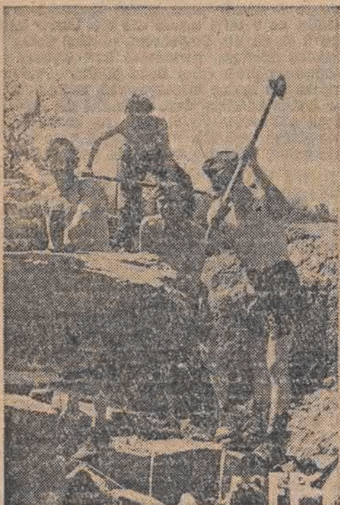
„Służba Polsce” — bataliony rzeszowskie we Wrocławiu przystąpiły do pracy w trzech punktach miasta. Odbudowa stadionu olimpijskiego, usuwanie ruin w mieście i budowa Wystawy Ziem Odzyskanych. Kilka kompanii pracuje przy niwelowaniu terenów wystawowych
