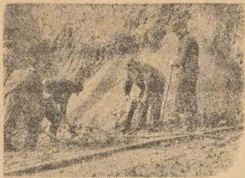
Wykonanie trasy W.-Z. na Placu Zamkowym w Warszawie.
