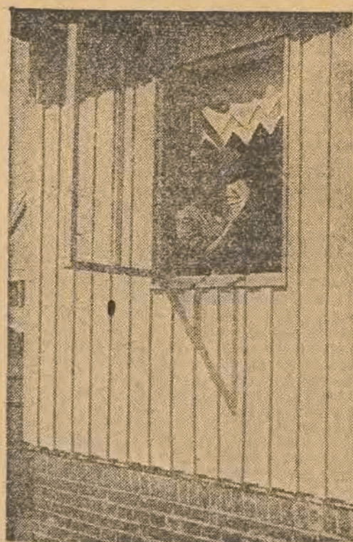
Biurowo Budowlane Przemysłu Węglowego przekazało 90 domków fińskich wykonanych wg planów polskich inżynierów na mieszkania dla pracowników Działu Przeladunków Morskich przy Centrali Zbytu Przemysłu Węglowego. Domki zostały wzniesione w ciągu 7 miesięcy na terenie obejmującym około 12 ha. we Wrzeszczu na osiedlu „Zaspy”. Wszystkie domki są skanalizowane. (Domek nr. 18 otrzymał Józwiak Stanisław, przodownik pracy. W oknie stoi żona Józwiaka z dzieckiem).
