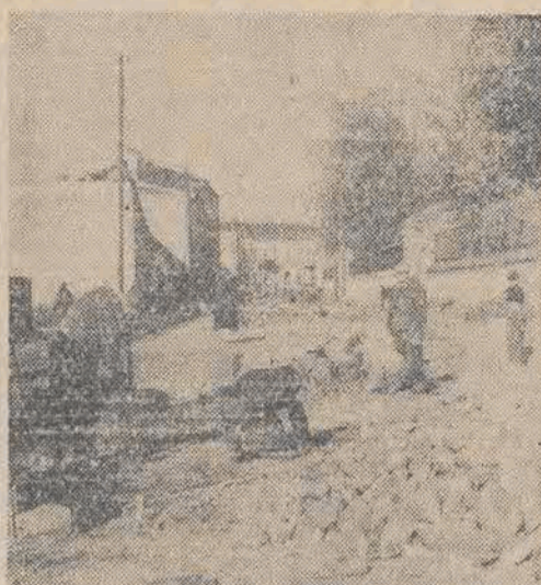
Zakładanie chodnika betonowego do Wilanowa
