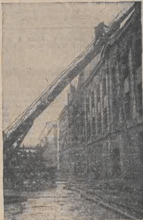
Do 1 października b. r., łódzka Straż Ogniowa musiała interweniować aż w 298 katastrofach budowlanych. Jak z tego wynika, katastrofy budowlane są w Łodzi znacznie większą plagą od pożarów. Dobrze, że strażacy nas nie upierają się przy swej zasadniczej specjalności i spieszą ofiarnie również na alarm: DOM SIĘ WALI!
