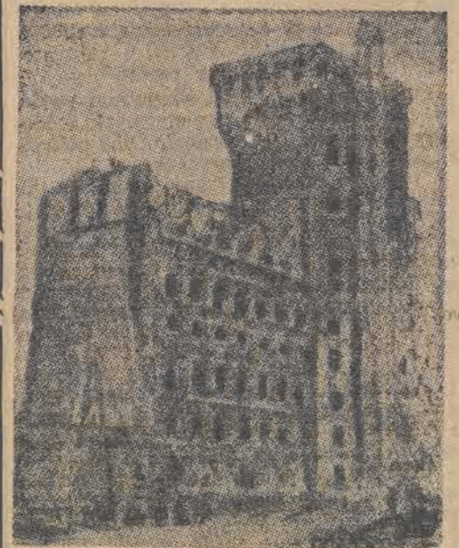
58-metrowej wysokości gmach Centrali Telefónów znajduje się w stadium odbudowy.
