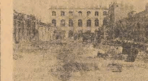
Północna dzielnica miasta uzyska niezadługo doniosłą placówkę zaopatrzenia jej mieszkańców w postaci wielkich, nowoczesnie urządzonej Hali Targowych. Budowa tych Halli w
