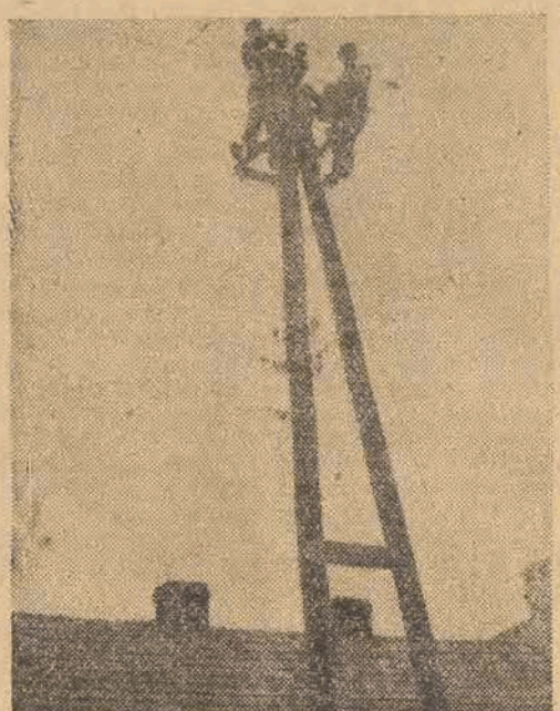
Naprawa linii wysokiego napięcia pod Łodzią
