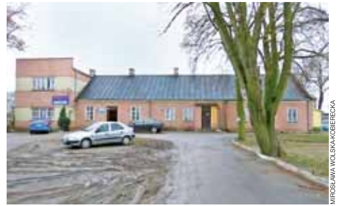
W ramach rewitalizacji centrum Zdun wyburzony będzie widoczny w tle parterowy budynek. Pomiędzy Urzędem Gminy a Domem Kultury powstaną parkingi, nowe ścieżki i zieleń.
