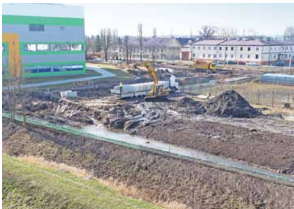
Prace nad korytem Bobrowki, mniej więcej w połowie realizacji. Widok z dachu biurowca zakładu z 25 lutego.
