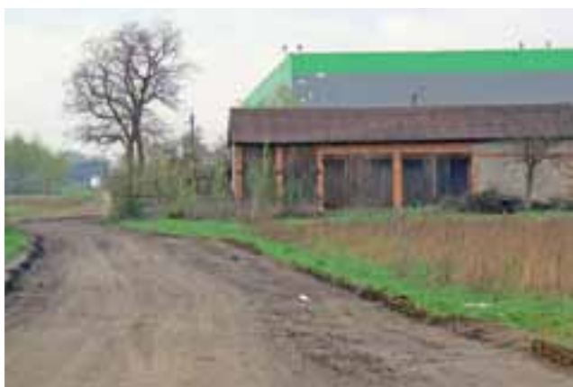
Gruntowy odcinek od nowego ronda do kostkowanej drogi wzdłuż magazynów zostanie w końcu wyasfaltowany.
