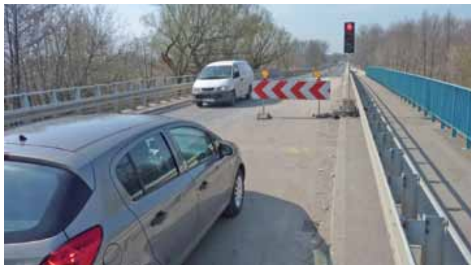
Tymczasowa sygnalizacja świetlna przed wjazdem na most na Rawce w Kolonii Bolimowskiej.
