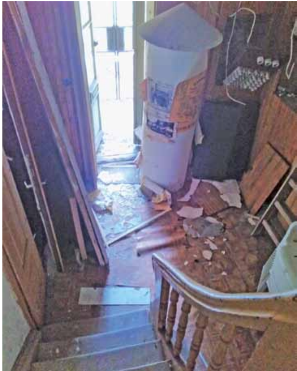
Stan po włamaniu - widok z góry.
