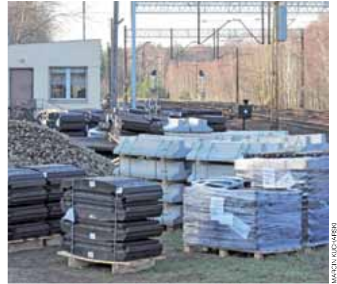
Materiały , które mają być wykorzystane podczas remontu przejazdu, zostały przywiezione do Arkadii w grudniu ubiegłego roku.
