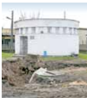
Przepompownia przy ul. Piłsudskiego – przed nią widać ślady prowadzonych aktualnie prac.
