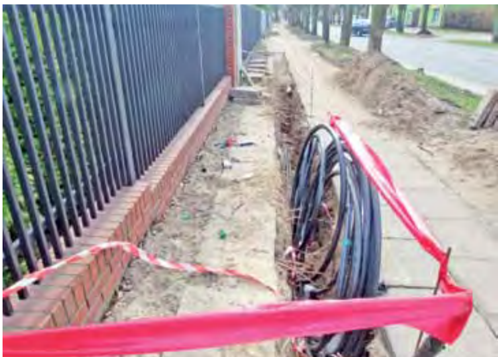
Kładziony kabel połączy Głowno z Piaskami Bankowymi.
