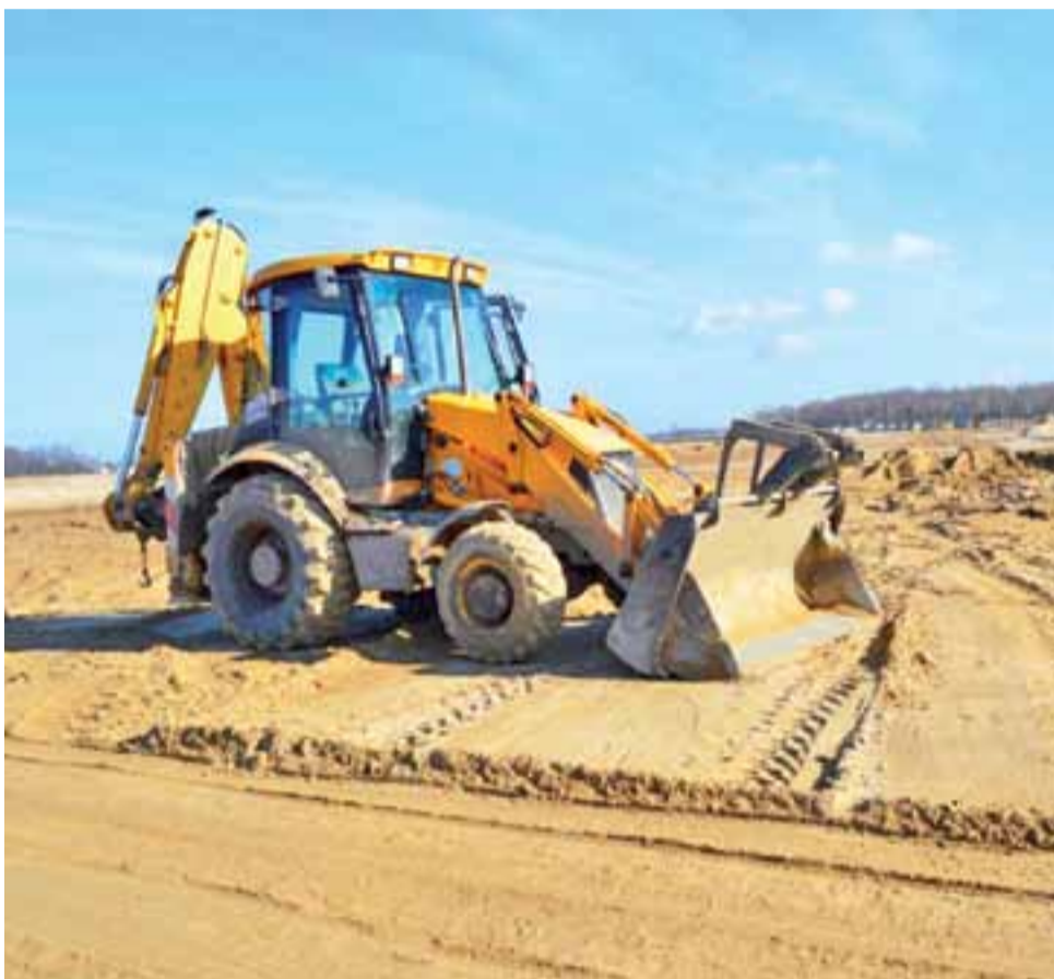
Trwają prace związane z podniesieniem i zagęszczeniem terenu pod budowę.
