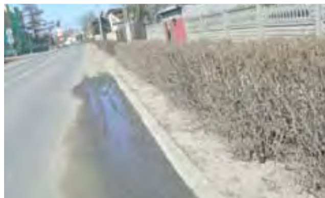
Tak w ubiegły czwartek wyglądał fragment jezdni i przyległy do niej żywoptot przy ul. Targowej. Zapach wskazywał, że mogą to być ścieki.
