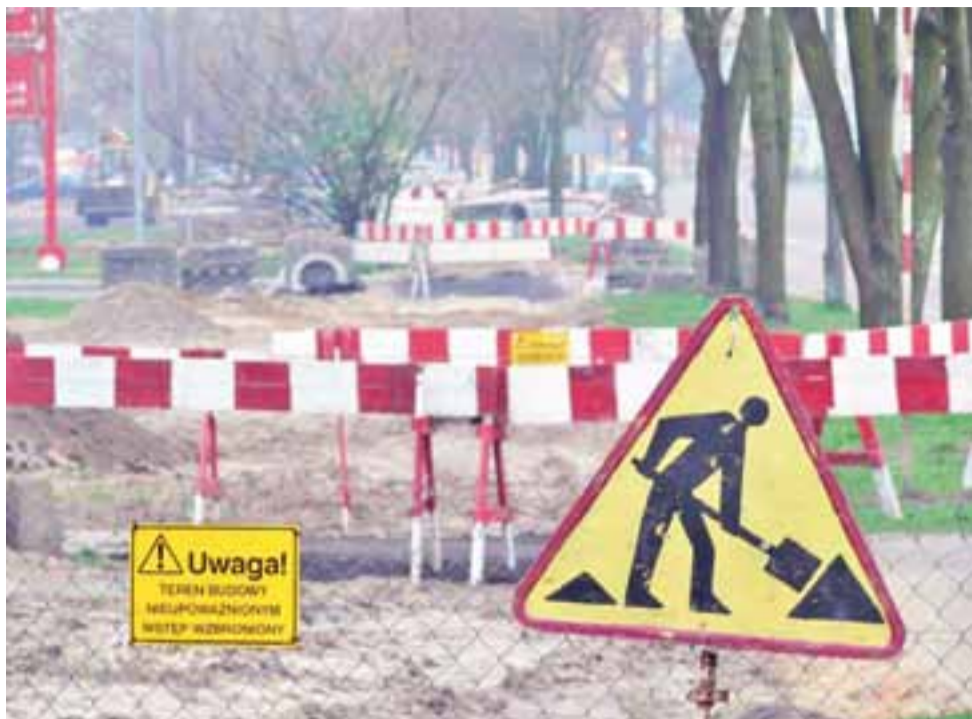
Prace przy budowie kanalizacji deszczowej spowodowały zniszczenie chodnika wzdłuż ul. Starzyńskiego. Firma ma czas do końca czerwca na jego odtworzenie.
