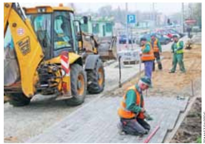
Pracownicy Zakładu Usług Komunalnych od 11 kwietnia zajmują się budową zatoki parkingowej i chodnika przy ul. Piłsudskiego, na wysokości blaszanych pawilonów. Roboty mają trwać do końca kwietnia. tb
