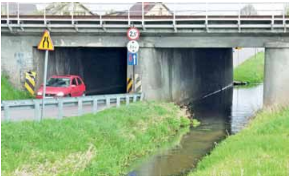
Pisia Zwierzyniec będzie w granicach miasta oczyszczona, w miejscu pod torami nie może zostać pogłębiona z uwagi na skrzynkową konstrukcję tunelu.
