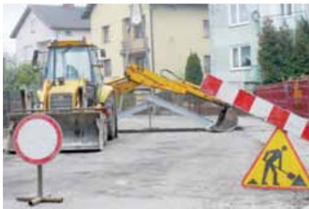
Tak wyglądała ul. Dolna podczas prac.
