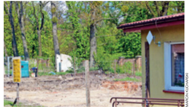
Budowa bloku socjalnego przy Fabrycznej dopiero się rozpoczęła.
