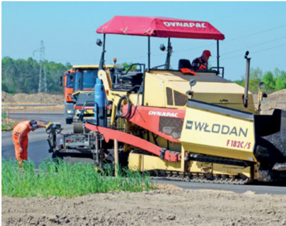
Pod koniec ubiegłego tygodnia wykonawca Toru Łódź układał już asfalt na grównej pętli, która liczyć będzie 17 zakrętów.
