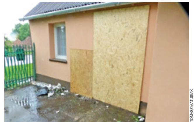
Przy pomocy sąsiadów pan Ryszard zakrył dziurę z użyciem takich płyt.
