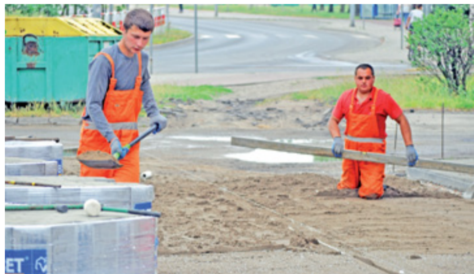
Układanie kostki na osiedlowych drogach na Bratkowicach zbliża się do końca.
