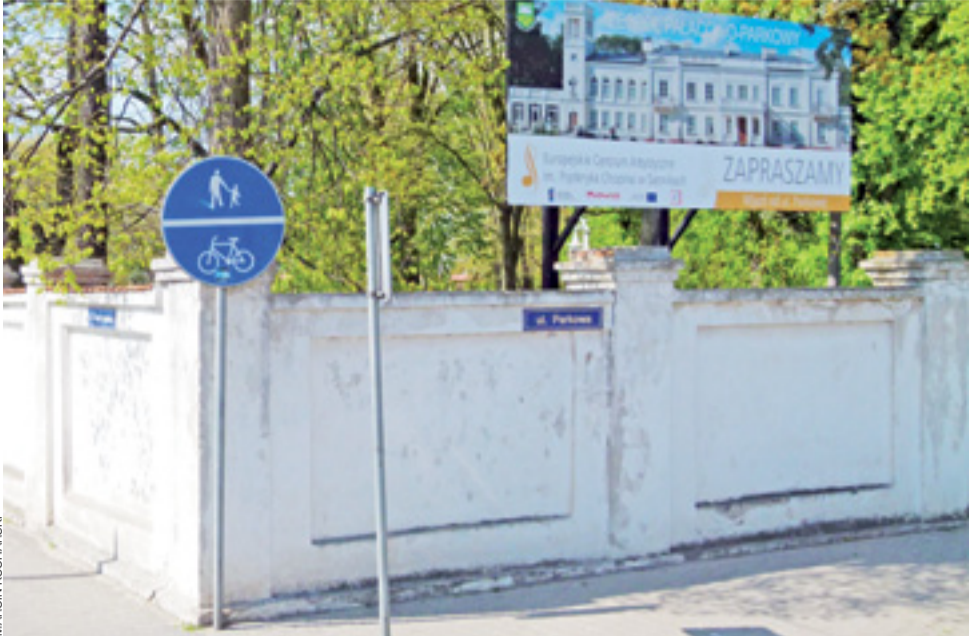
Ażurowe ogrodzenie będzie tylko od strony ul. Parkowej, od ulicy Warszawskiej ogrodzenie się nie zmieni.
