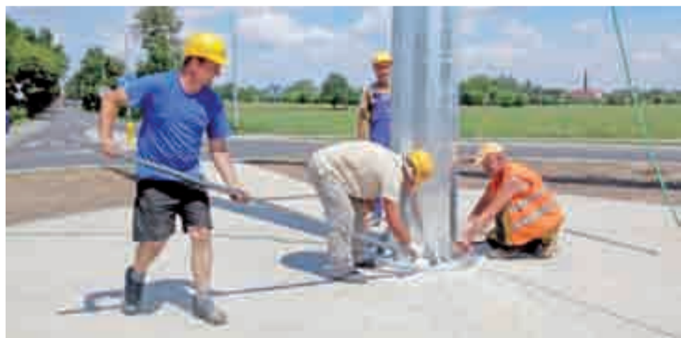
Maszt wysokości 22 m na Rondzie Niepodległości montowany był w poniedziałek, 1 lipca. Dzisiaj uroczystość zostanie na niego wciągnięta flaga Łowicza.
