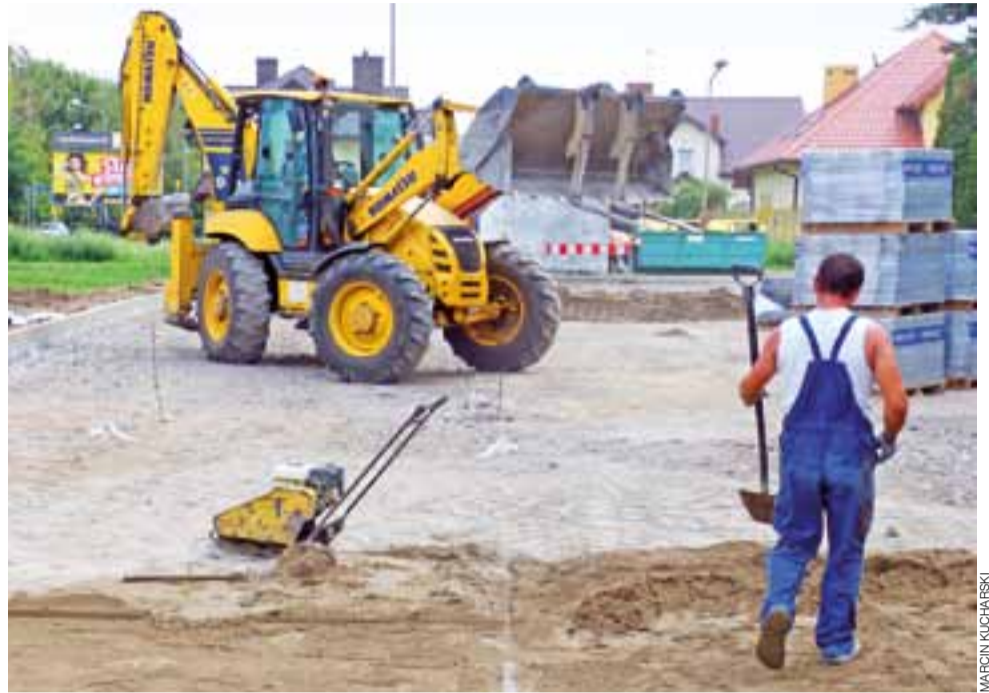
Teren pod parking, drogę i chodniki w sąsiedztwie bloku nr 27 na Bratkowicach został utwardzony, układanie kostki powinno zakończyć się do 6 sierpnia.
