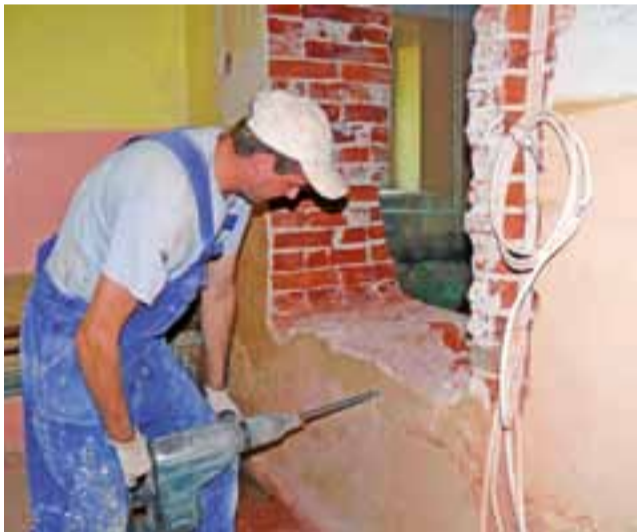
Pracownicy firmy Insbud ze Skierniewic prowadzą prace rozbiórkowe w miejscu, gdzie powstanie nowoczesna kuchnia.
