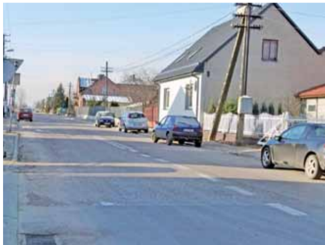
Ulica Żychlińska w Kiernozi nie jest jeszcze skanalizowana.
