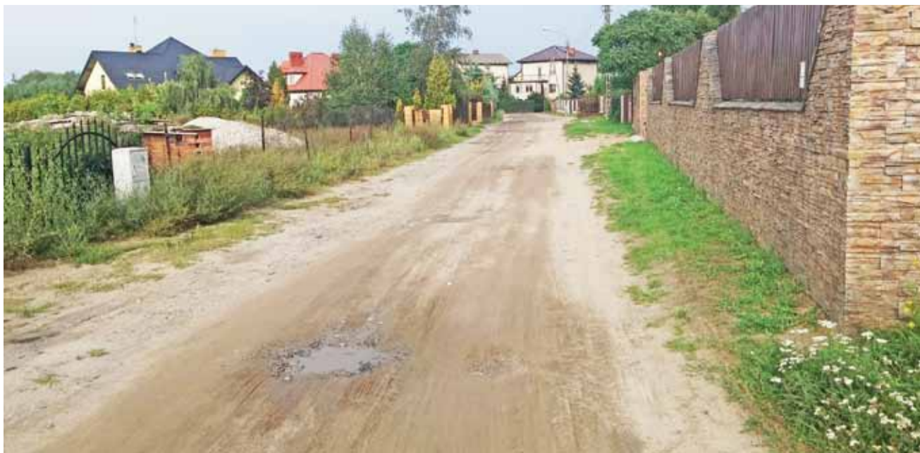
Ulica Chabrowa to obecnie gruntowa, położona na uboczu, nieutwardzona droga, przy której znajduje się kilka zamieszkałych posesji.
