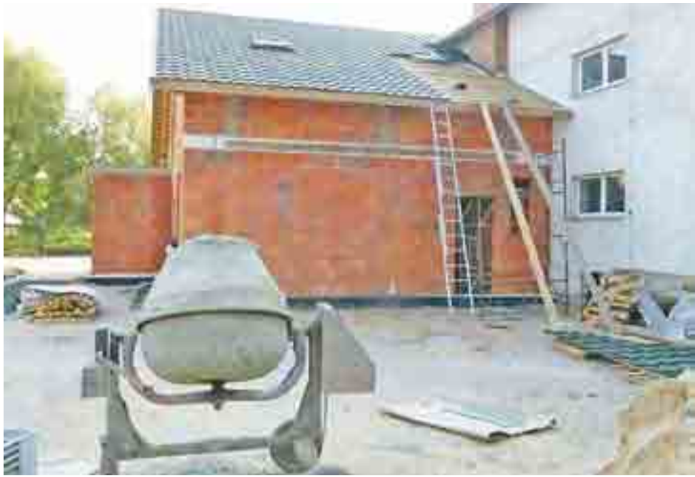
Zrzeszenie plantatorów na zakupionej działce buduje pomieszczenie biurowe wraz z salą konferencyjną.
