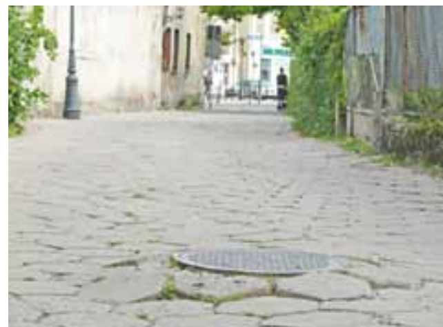
Ulica Wąska znajduje się w centrum miasta, jej nawierzchnia wykonana jest z trylinki i nie należy do najrówniejszych, dlatego zostanie zmieniona.
