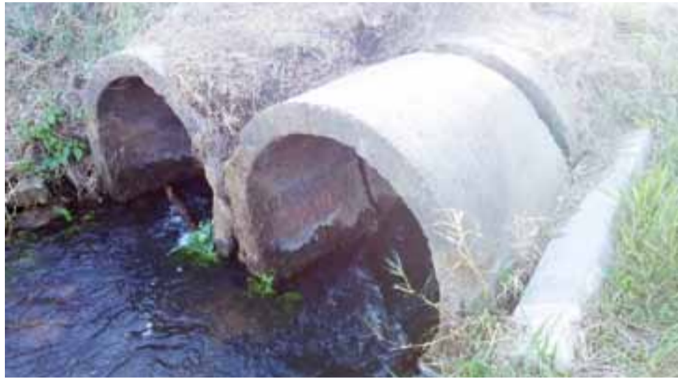
Od lat most na Otolance, zastępujący dwa betonowe kłęgi ułożone w nurcie rzeki i zasypane ziemią. W przyszłym roku może się to zmienić.
