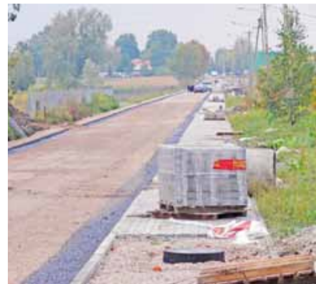
Ulica Strzelczewska widziana od strony ul. Chełmońskiego jest przygotowana do położenia masy bitumicznej, chodnik także jest już prawie gotowy.
