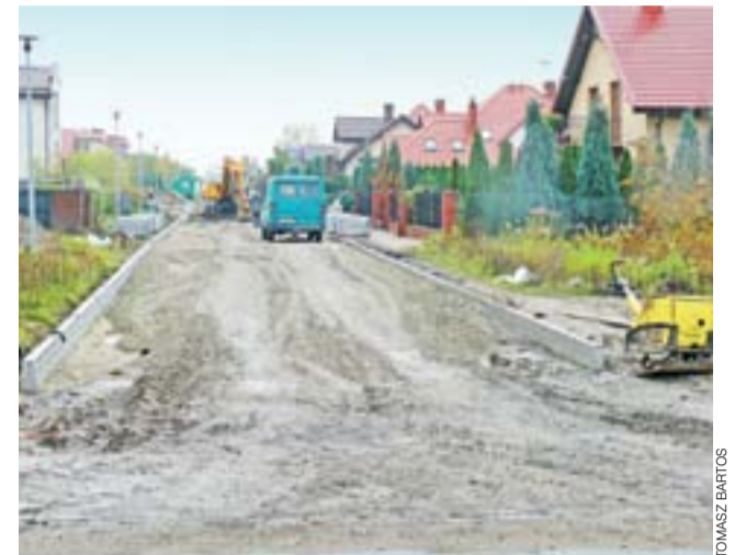
Na ulicy Szafirowej widać już przygotowaną podbudowę pod nawierzchnię, ta z kolei jest już układana na ul. Topazowej.
