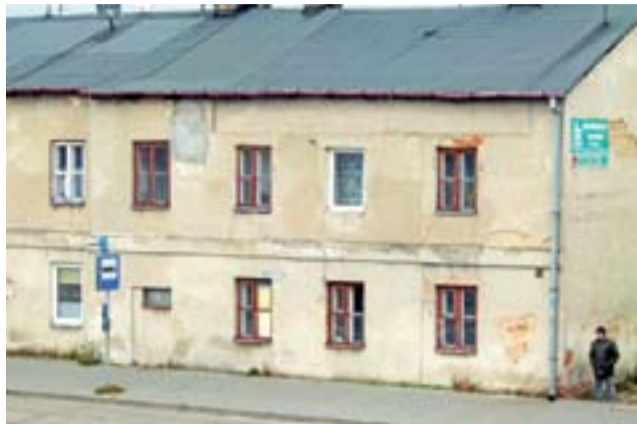
Budynek przy Warszawskiej – ostatnie dni przed rozbiórką.
