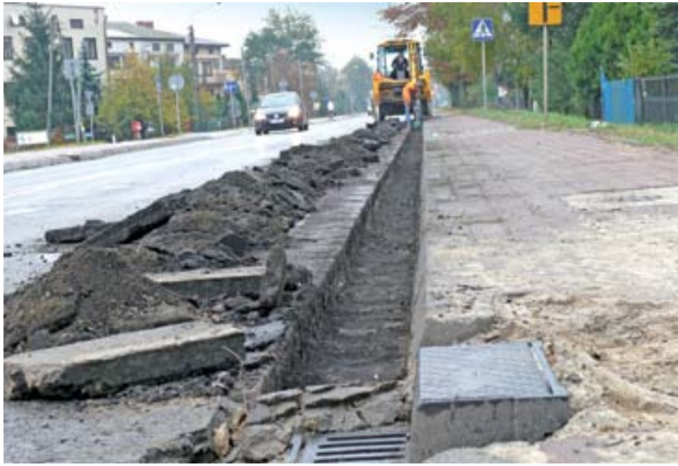
W wyciętym i wybranym asfalcie zostanie ułożona betonowa kostka, woda spłynie ściekiem do kraty, skąd skierowana będzie do rowu.
