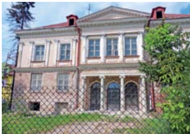
Zdjęcie budynku przy 3 Maja 7, które wykonał na początku sierpnia. Prace przy skuwaniu tynku zostały wówczas przerwane.
