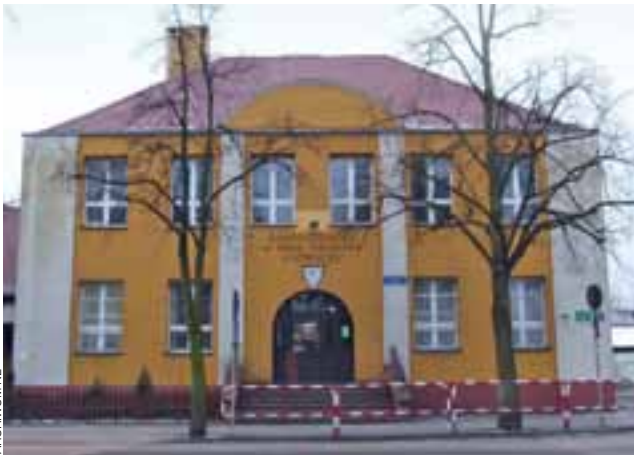
Budynek Gimnazjum nr 2 im. Jana Wegnera przy ul. A. Mickiewicza w Łowiczu.
