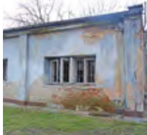
Tak wygląda budynek po dawnej „Piątce”, znajdujący się za Szkołą Podstawową nr 4. Czy doczeka się rozbioru?
