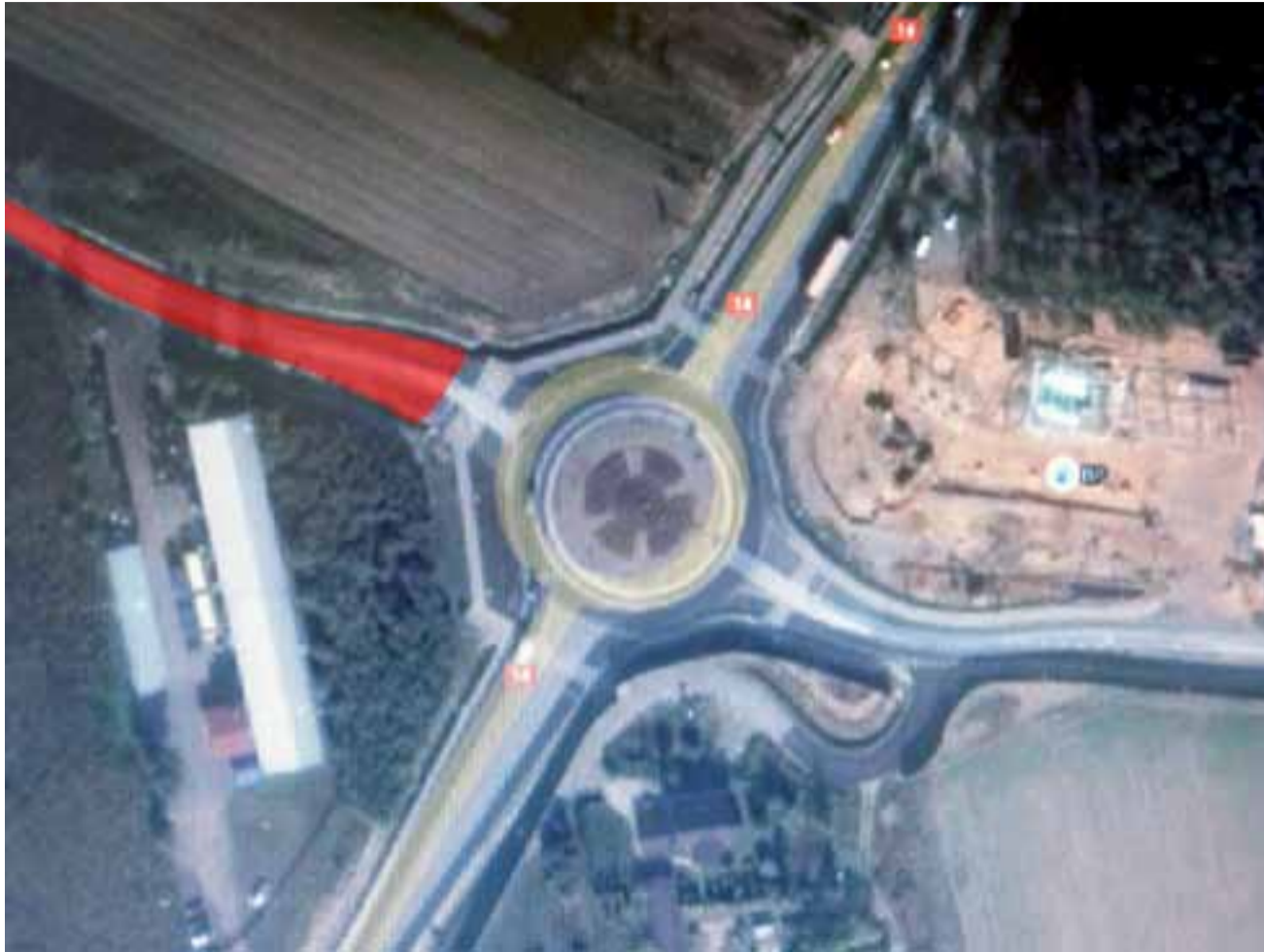
Rondo łączące Sosnowiec Pieńki i Sosnowiec z drogą krajową nr 14. Jeszcze w tym roku gruntowy fragment drogi z kierunku Sosnowca (od lewej) zostanie uzupełniony asfaltem.
