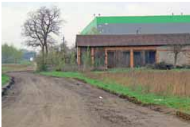
Gruntowy odcinek od nowego ronda do kostkowanej drogi wzdłuż magazynów zostanie w końcu wyasfaltowany.
