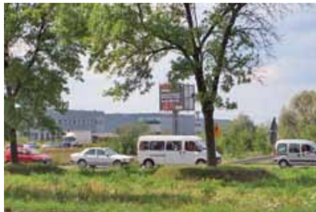
Gmina chce rozkorkować wyjazd z terenów magazynowych Segro na trasę krajową nr 14, budując nowy odcinek drogi Smolice – Norty.
