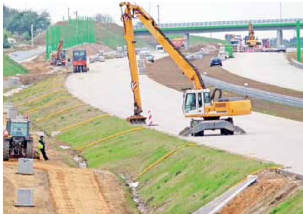
Anielin. Widok z wiaduktu na roboty obejmujące odcinek budowanej A-1 w kierunku Sierżni.
