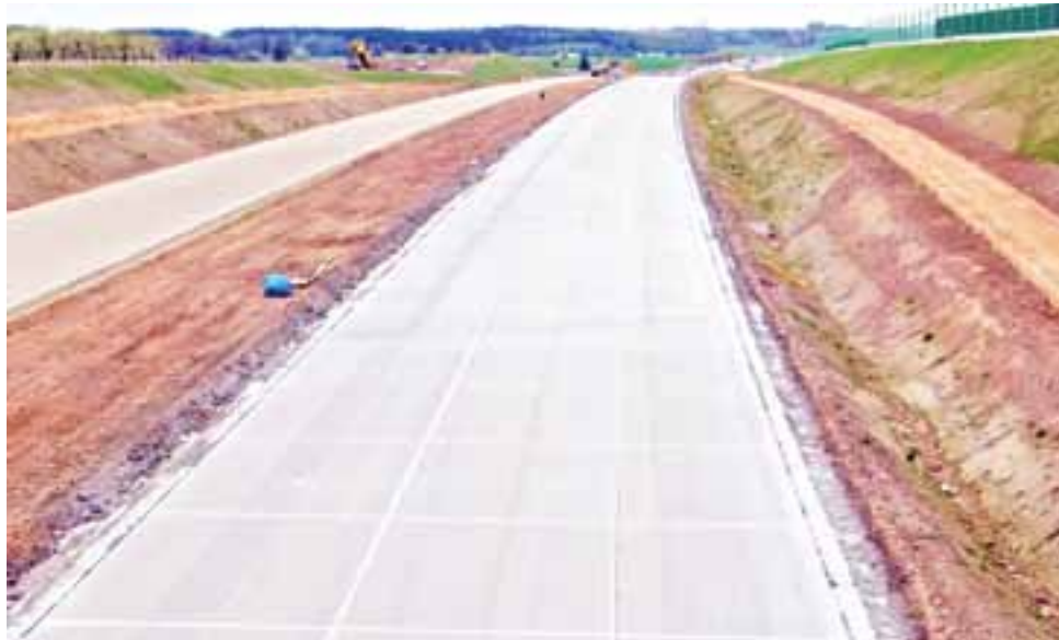
Betonowa nawierzchnia odcinka A-1 biegnącego przez Sierźnię w kierunku Janinowa (pow. brzeziński) już gotowa.
