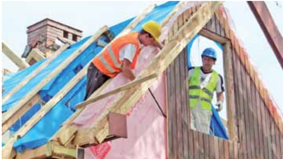
Dachówka i część więzby dachowej już zdjęta. Rozbiórka ma zakończyć się do połowy czerwca.
