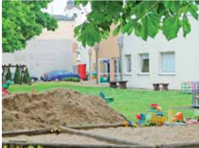
Przedszkole Samorządowe w Strykowie, przebudowane 6 lat temu, już wymaga kosztownych nakładów. Gmina toczy z wykonawcą spór sądowy.
