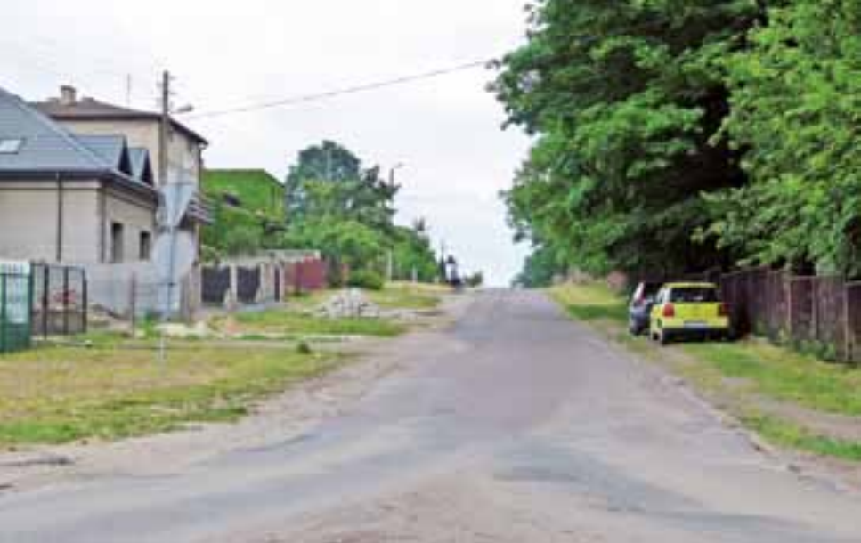
Ulica Żwirki doczeka się gruntownej przebudowy.
