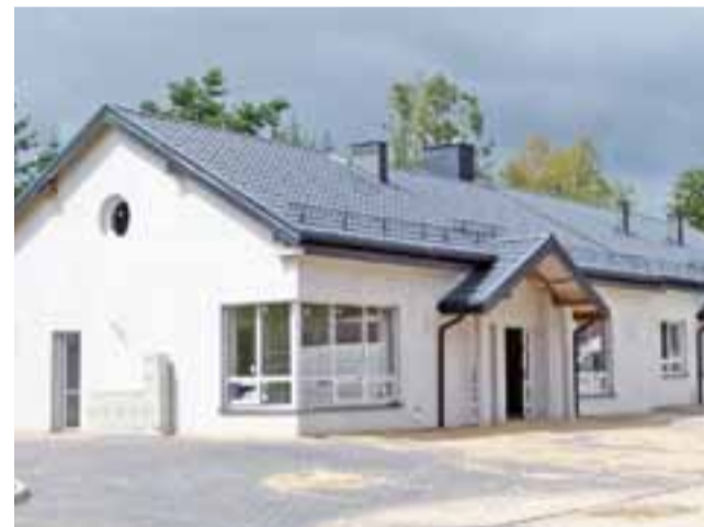
Nowy budynek przychodni z zewnątrz wymaga jeszcze malowania.
