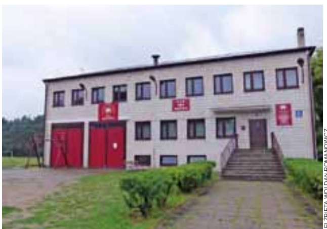
Nowe tablice już zamontowane na strażnicy OSP.
