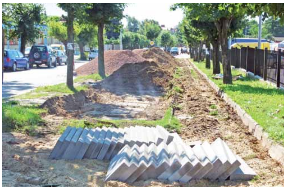
W tym miejscu niedługo powstanie parking.
