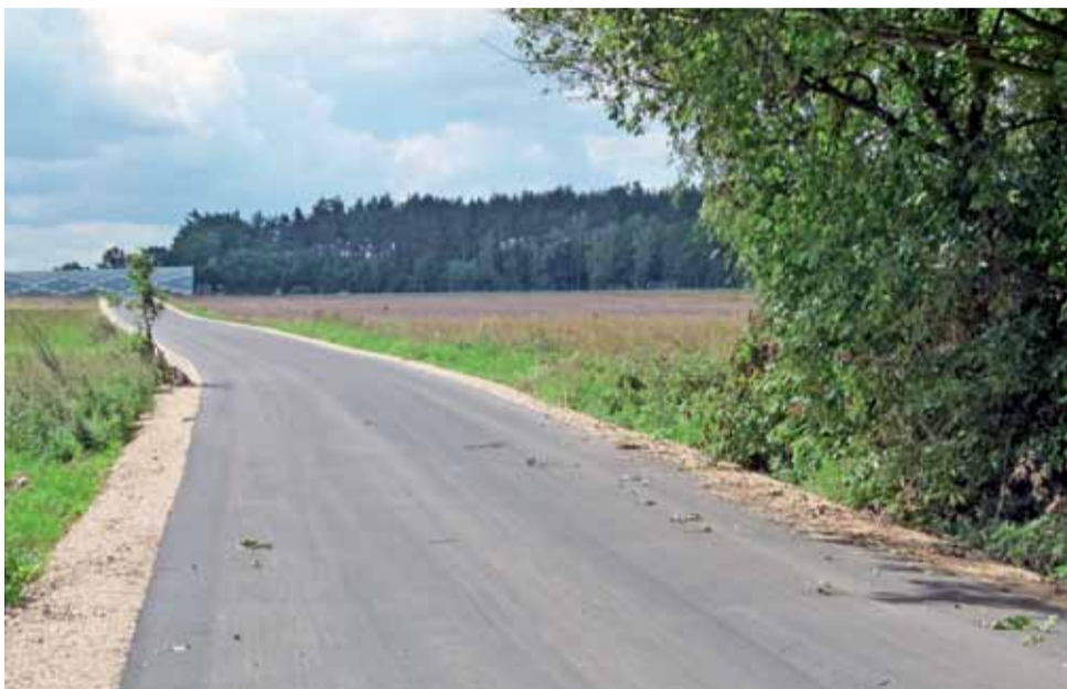
Tu była gruntówka. Droga ta została utwardzona przez firmę Erbedim.
