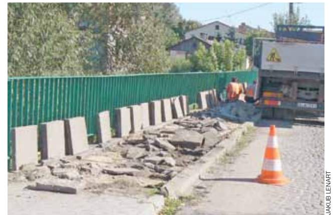
Stare płyty na moście zastąpi kostka brukowa.
