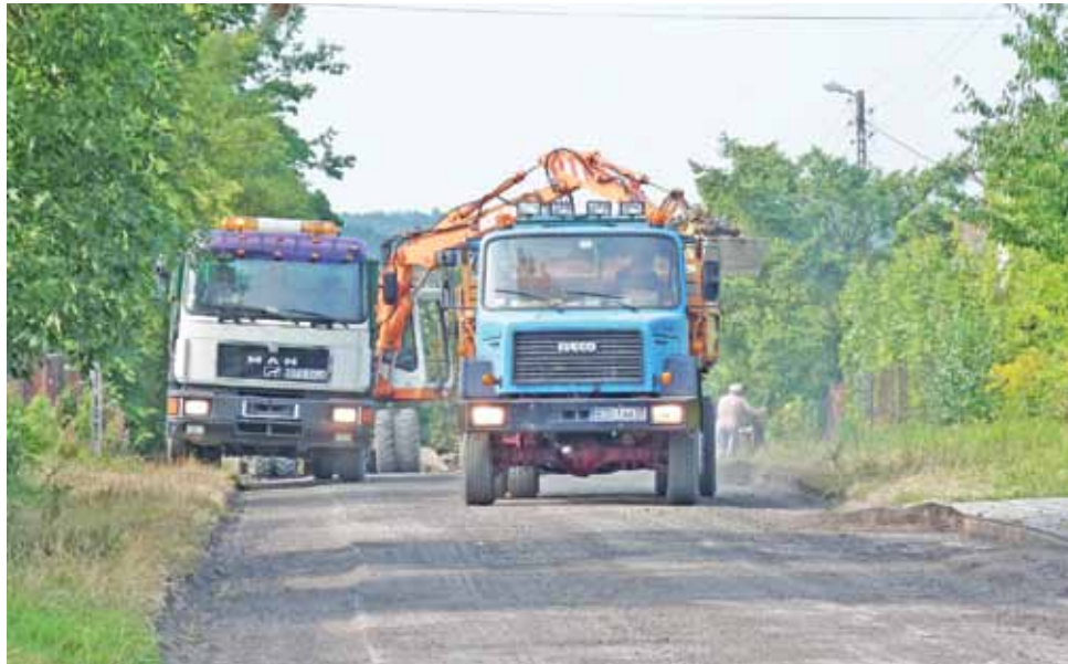
Na ul. Żwirki zerwana już została stara nawierzchnia.
