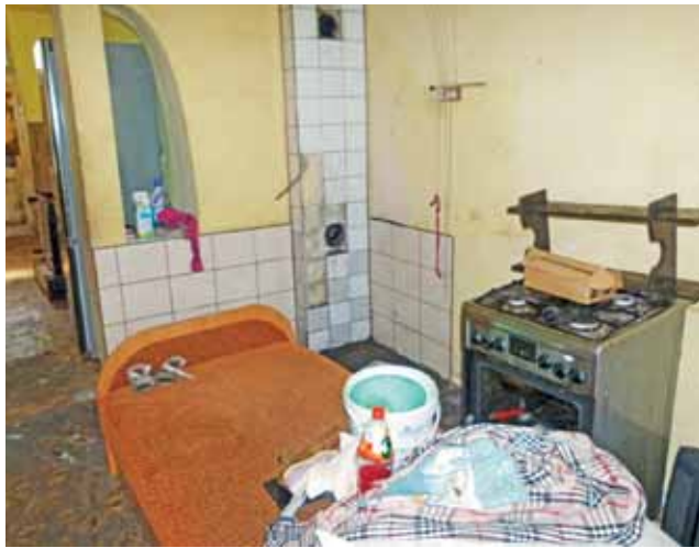
Na Moczydłach. Dla pozbawionych dachu nad głową ludzi w zasobie komunalnym znalazło się jedynie mieszkanie wymagające gruntownego remontu.
