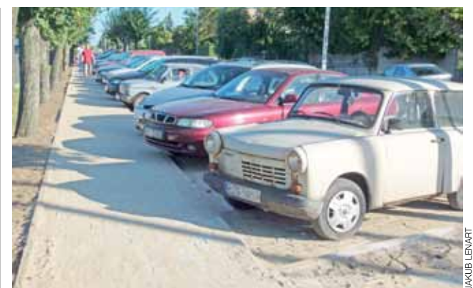
W ramach inwestycji wybudowano nowy parking.
