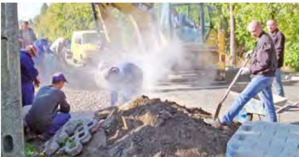
Pracownicy MZK budują zjazdy przy Dworskiej.
