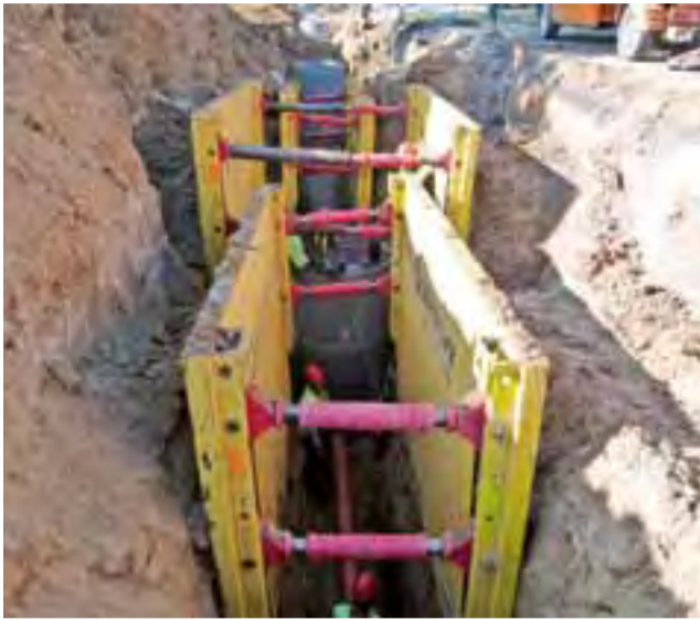
Trwają zaawansowane prace przy ul. Żwirki.
