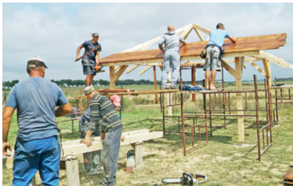
Mieszkańcy sołectwa w czynnie społecznym wybudowali i zaimpregnowali drewnianą altanę.
